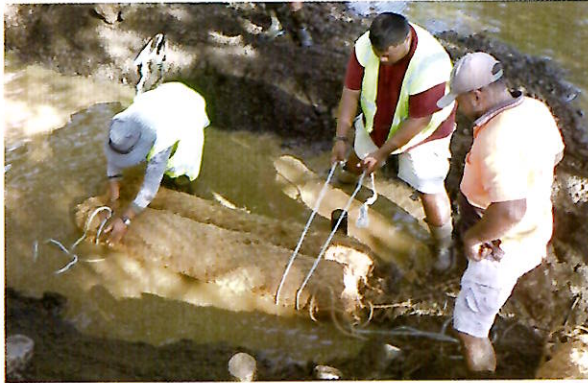
ブルーバード社による剝離したバイオログフィルターの修繕工事【2024年6月】
